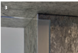
3 Collé contre le mur avec laquage partiel
