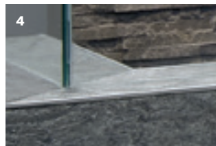
4 Encastré dans le sol avec profil UP
