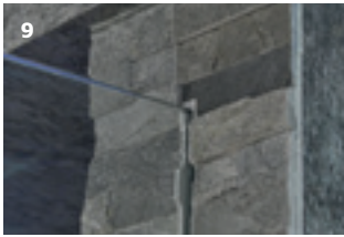
9 Senza elementi di fissaggio visibili con profilo a incasso
