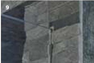
9 Ohne sichtbare Befestigung mit UP-Profil Sans fixation visible avec profil UP encastré
