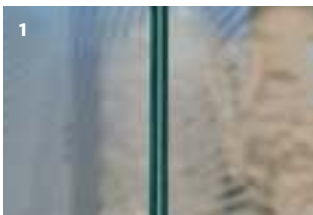
1 Verklebung Glas / Glas in Gehrung Collage verre / verre dans l'angle
