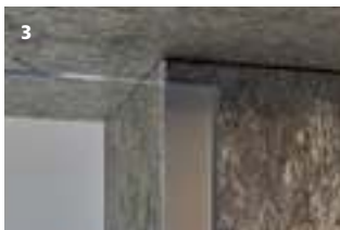
3 Auf die Vormauer geklebt mit Teillackierung Collé contre le mur avec laquage partiel
